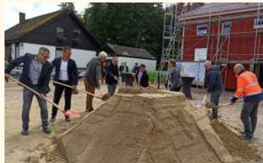
Spatenstich im Industriegebiet Süd: Die Firma Pfau errichtet auf dem Gelände gegenüber der Seemannsklause ihren neuen Unternehmenssitz, der sich von Römerberg nach Haßloch verlagert.
